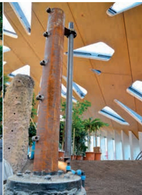
Die Sandbewässerung wird mit Stahlrohren geschützt.
